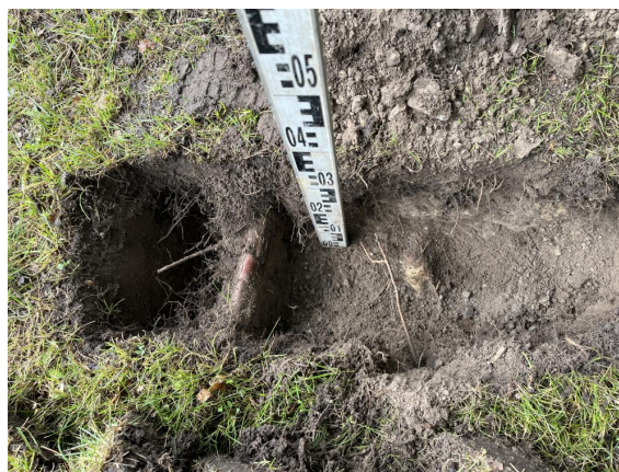
3.5.1 - Figuur 3: Proefsleuf boom 43
