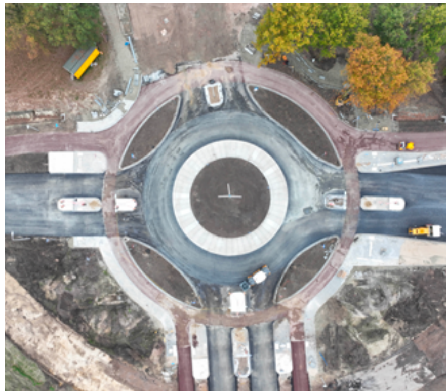
| Aanleg rotonde Kattestraat-Hoevenseweg en de Floralaan.
