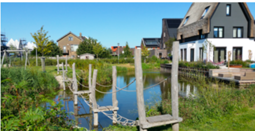
| Water opvangen in een wadi met speeltoestellen. Bron: Nanda Sluijsmans.
